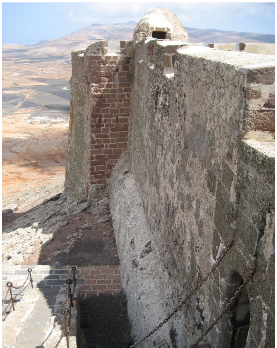
Blick vom Turm auf den Eingangsbereich. Die Prinzipien der guten Einsehbarkeit und einer massiven Außenhaut haben bis heute in der taktischen Architektur Gültigkeit.
